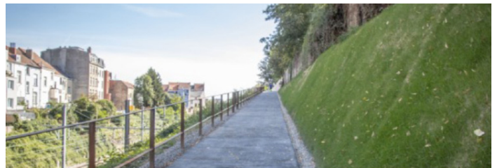
REF: Liaison cyclo-piétonne Wavre-Viaduc-Sceptre, Beliris / Fiets-voetgangerverbinding Waver-Viaduct-Scepter, Beliris
